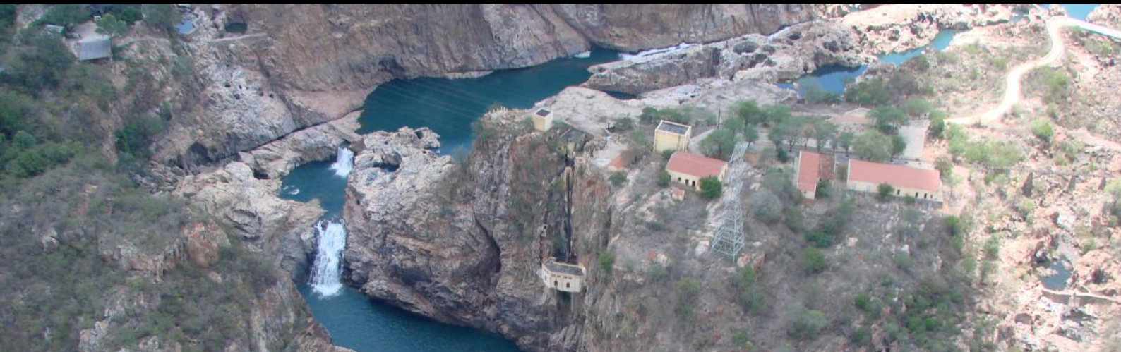
Usina Hidrelétrica de Angiquinho
